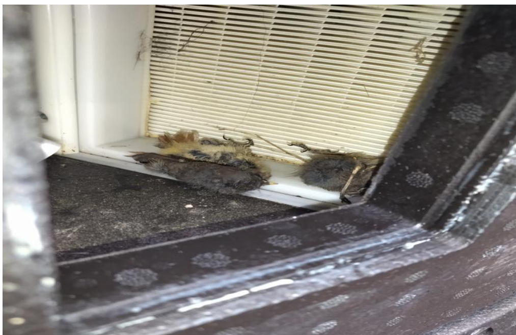
Obrázek 3 – Nečistoty (ptáčata) v prostoru rekuperačního výměníku
